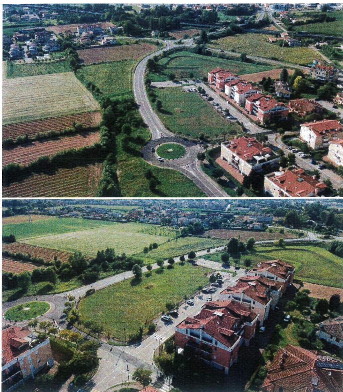
Figura 17. Immagini rilievo traffico con Drone – Ambito di intervento.
